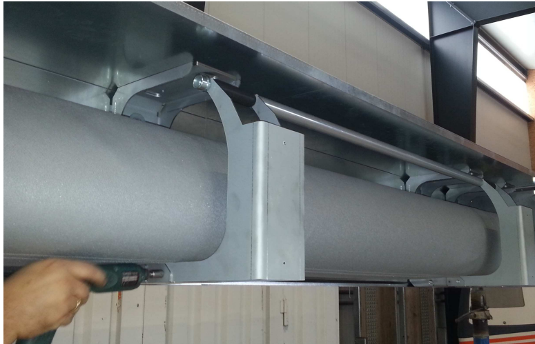
Bild 12: Konsole Wickelgehäuse
