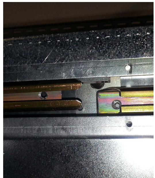
Bild 9: MEA-Schienenstoß (bei 2-teiliger Schiene)
